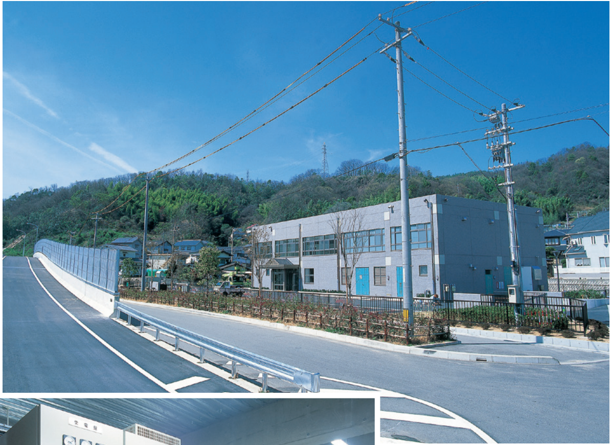
トンネル電気室
