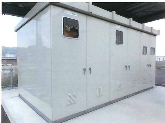
24kV受電盤 24kV VCT盤(買電用) 24kV VCT盤(売電用)
