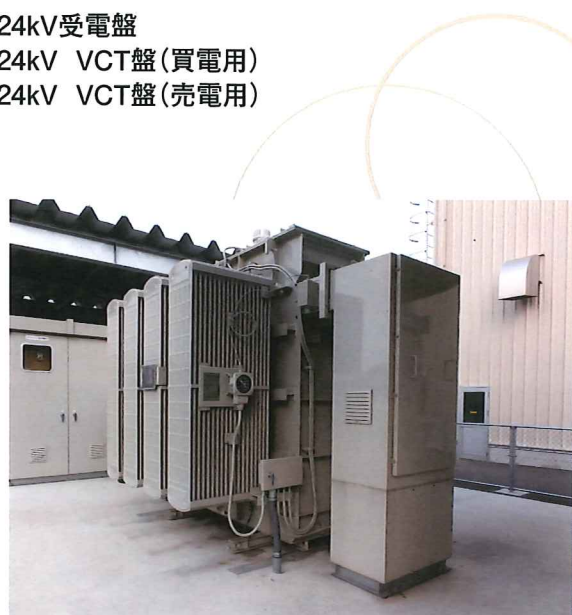
24kV/6kV7000kVA変圧器
