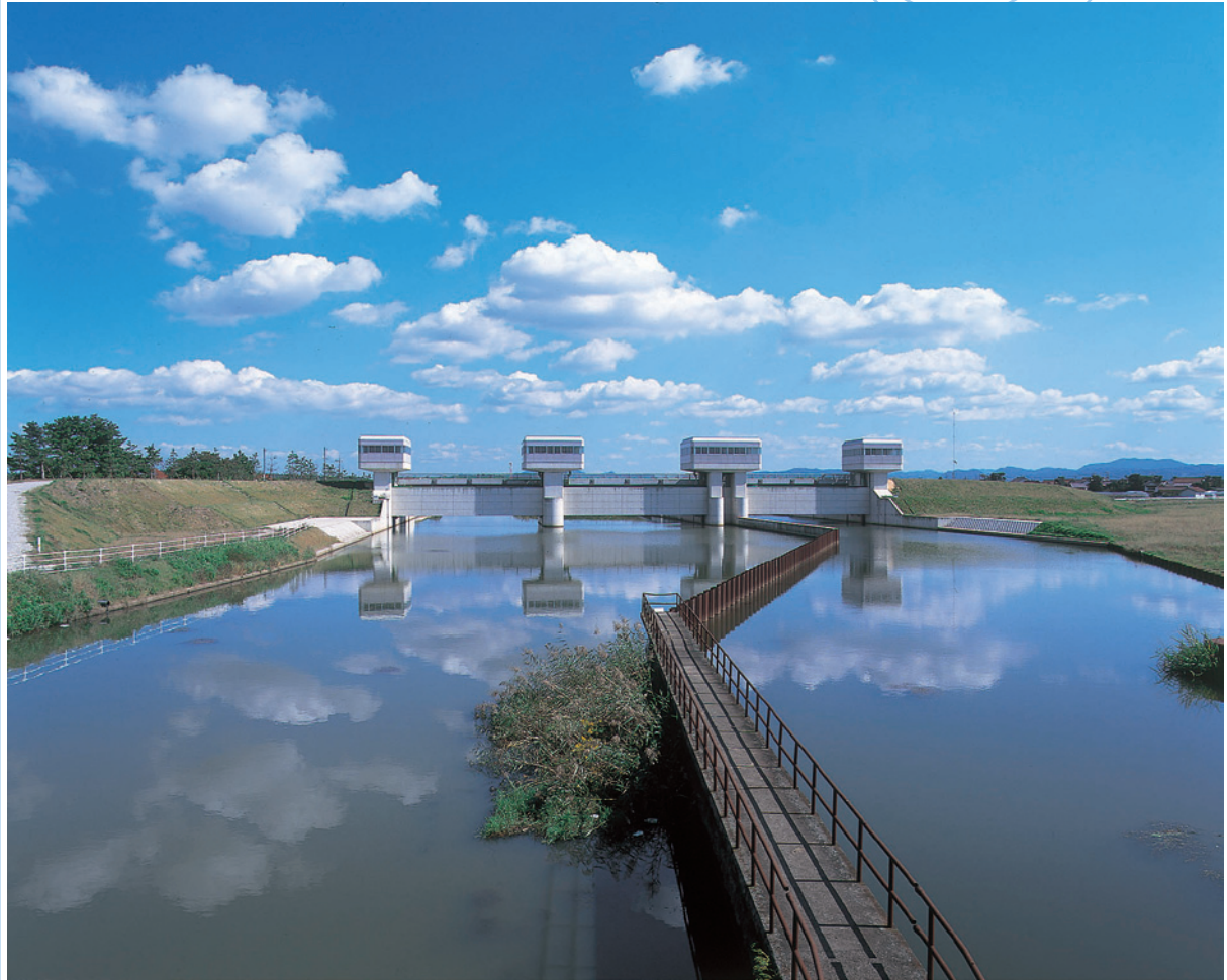
水門ゲート全景
